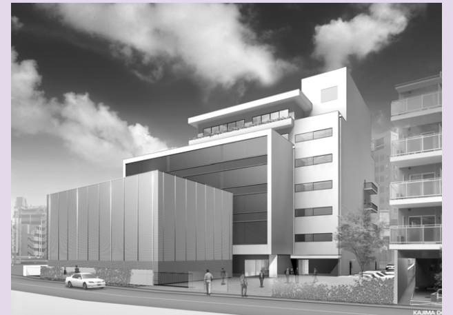
■2008年11月にオープンする第4のデータセンター
